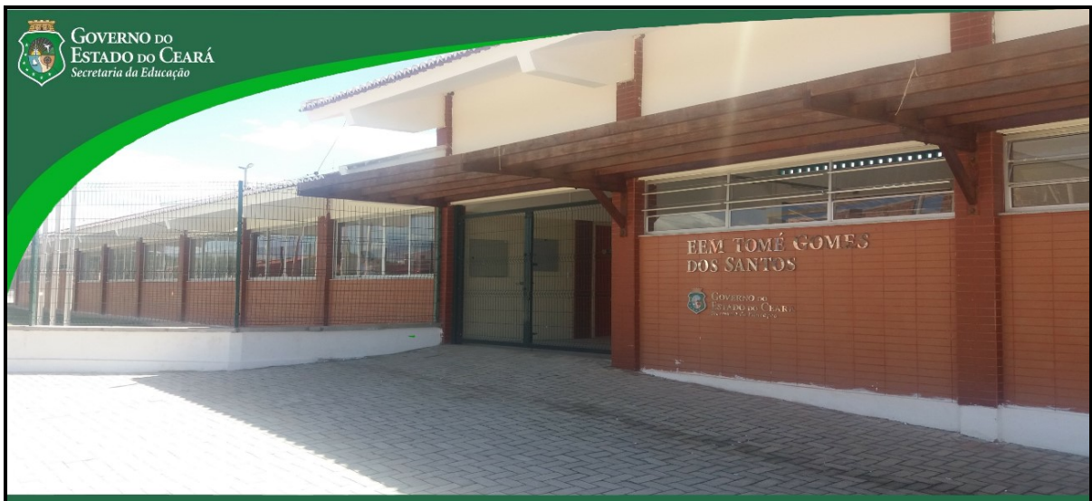
Figura 11 – Fachada da escola Estadual de Ensino Médio Tomé Gomes
